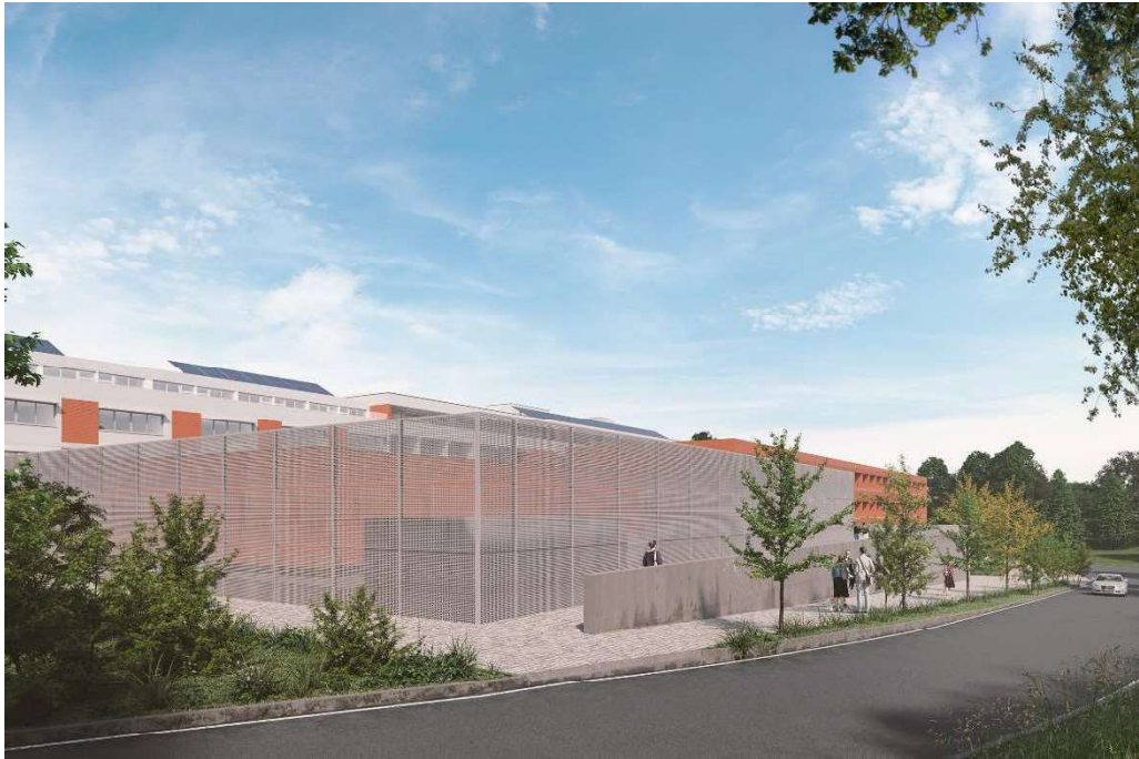
Figura 2 – Vista do espaço exterior adjacente ao Data Center
