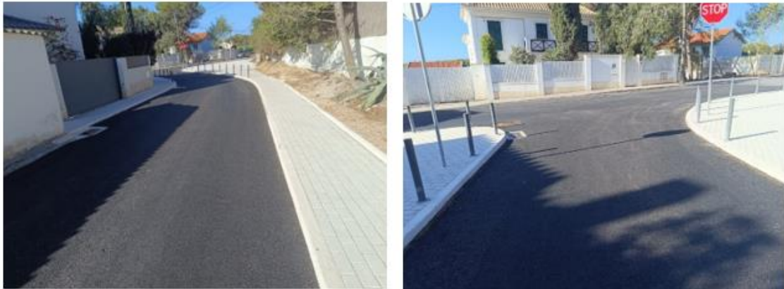
Figura 14 - Pavimentação da Rua Alexandre Pristas
