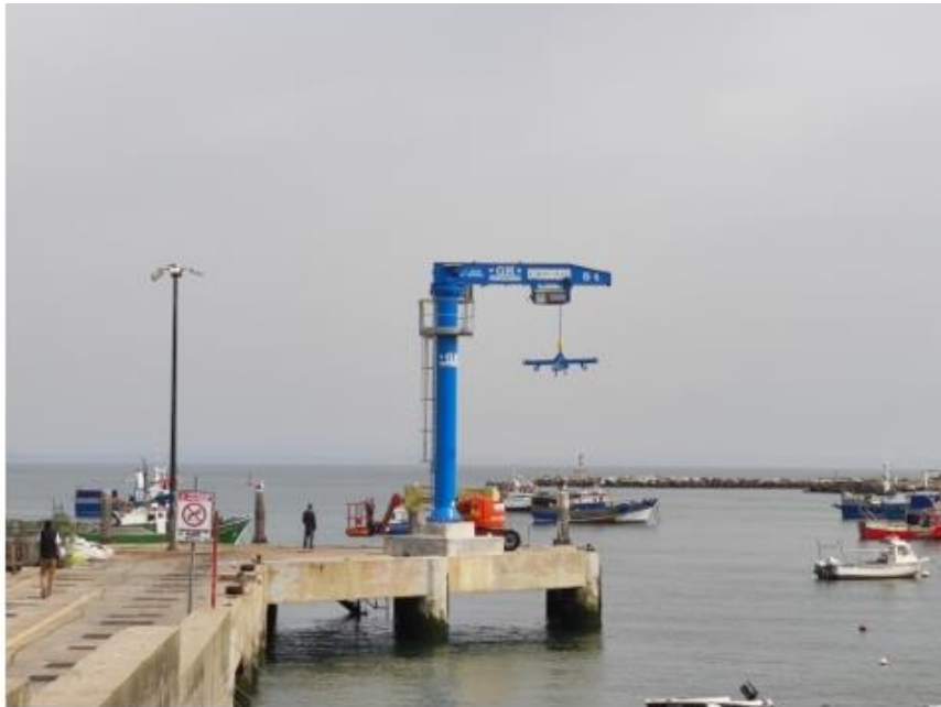
Figura 23 - Instalação de grua no pontão de Cascais
