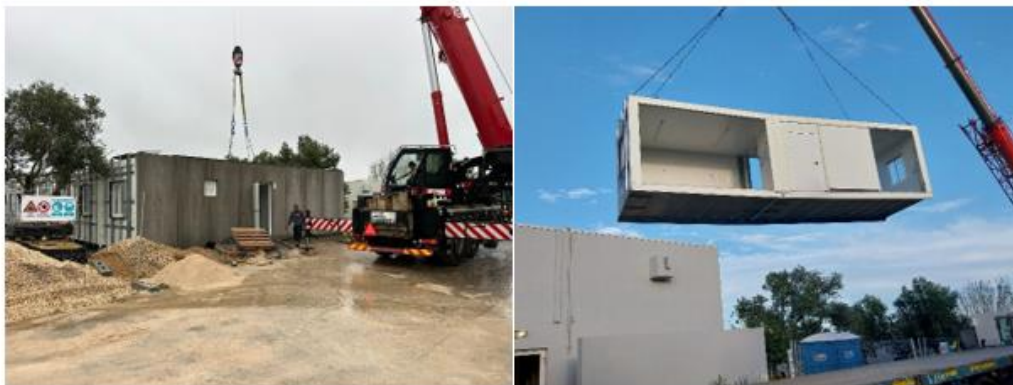
Figura 26 - Requalificação das instalações do veterinário municipal
