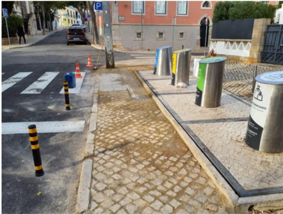
Figura 16 - Repavimentação e execução de lajetas de encaminhamento para passadeira
