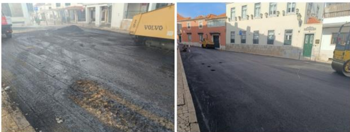
Figura 15 - Execução de fresagem e repavimentação da Rua Alexandre Herculano
