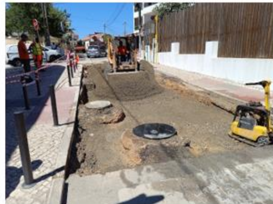
Figura 13 - Escavação para drenagem e aplicação de solo-cimento na Rua Carlos Anjos
