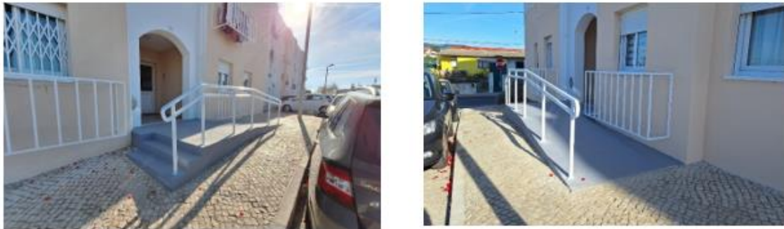
Figura 7 - Execução de rampa de acesso para mobilidade condicionada
