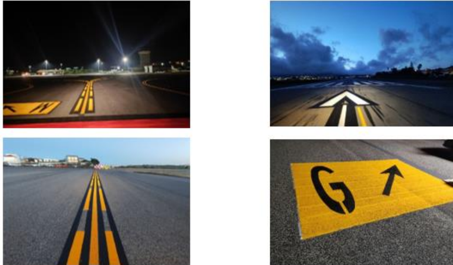
Figura 21 - Repintura de sinalização do Aeroporto de Cascais
