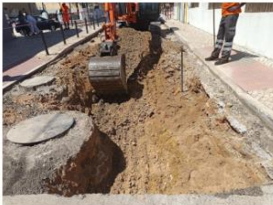
Figura 13 - Escavação para drenagem e aplicação de solo-cimento na Rua Carlos Anjos
