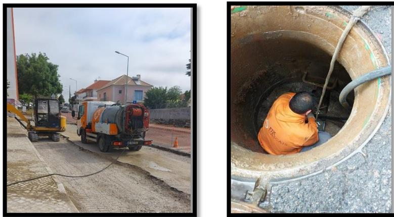
Figura 7 - Limpeza de coletores
