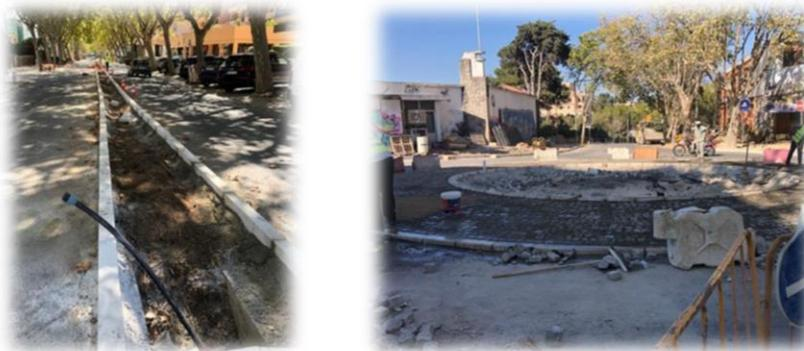
Figura 8 - Execução de separador central e rotunda Av. 25 de Abril
