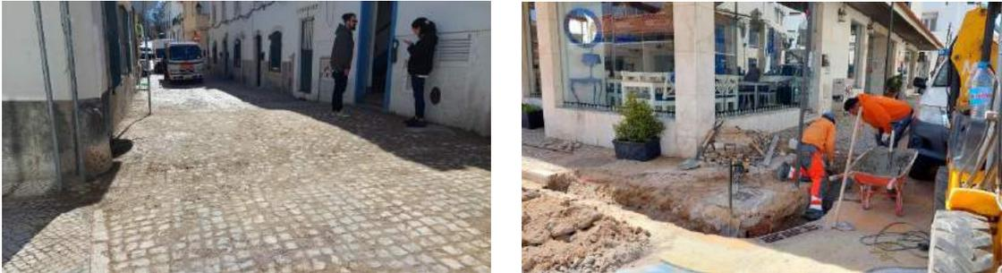
**Figura 8 –Execução de pavimentos em calçada e rebaixamento de lancis, na Rua Amarela, em Cascais**
