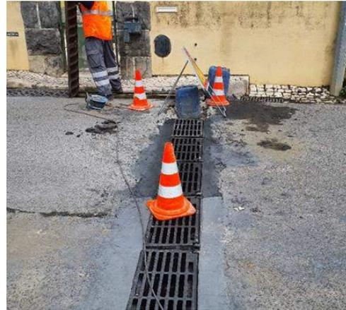
**Figura 10 - Execução de sumidouros e limpeza/manutenção da rede escoamento pluvial existente**
