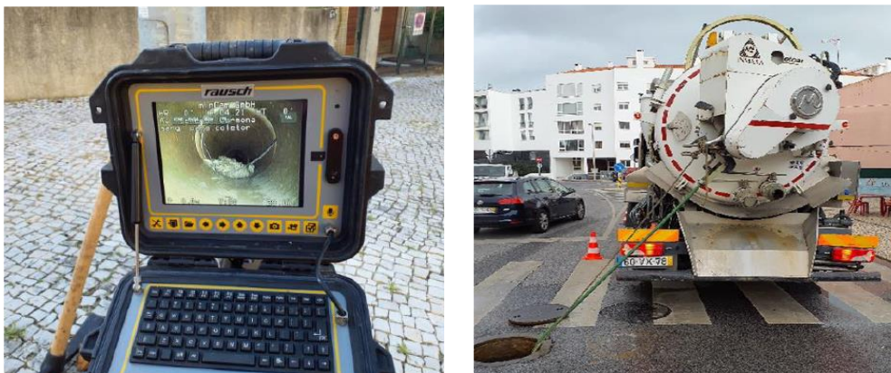
Figura 6 - Filmagem e limpeza de coletores
