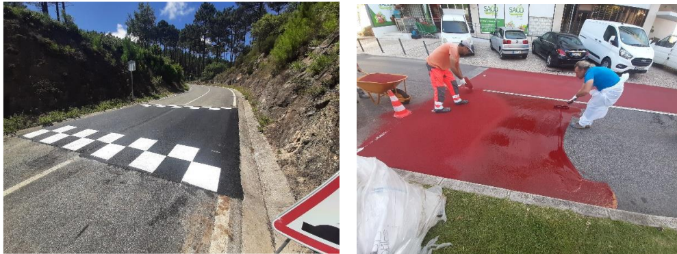
Figura 5 - Sinalização da Estrada da Serra e aplicação de tire gryp
