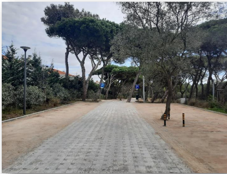
Figura 9 - Obras de beneficiação Parque da Pampilheira
