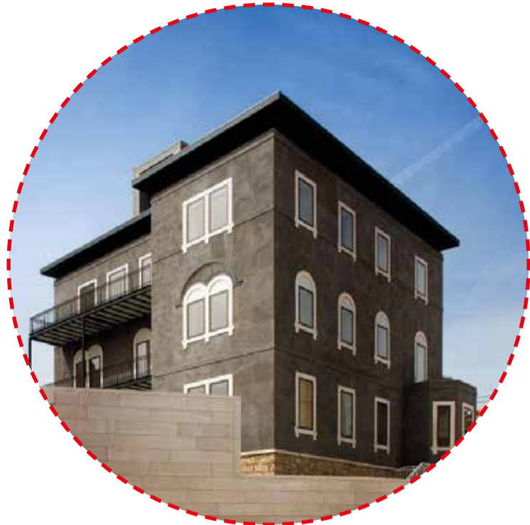
CONSERVATÓRIO DE MÚSICA DE CASCAIS e SEDE DA OCCO ARX ARQUITETOS FEVEREIRO 2008 € 1.200.000,00
