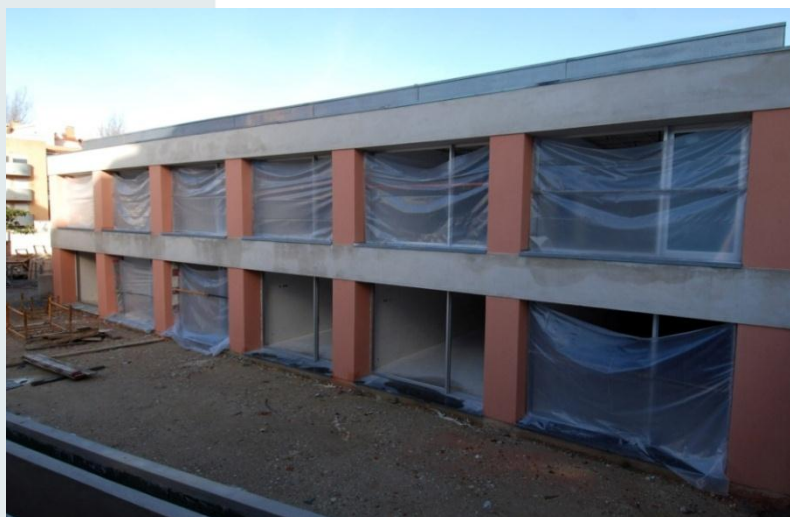
Ampliação e Creche do Centro Comunitário de Carcavelos
