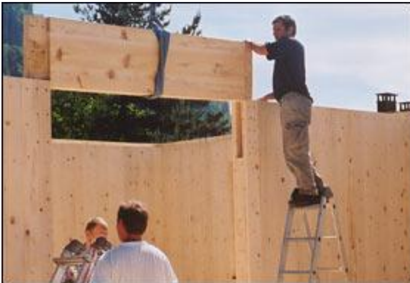
Figure 2 : La maison écologique existe, construite avec des matériaux avérés conviviaux comme le bois et parfaitement recyclable car les pièces de construction (panneaux) ne comporte ni clous ni colle avec la technique du panneau chevillé. (Firme Thoma, Autriche)
